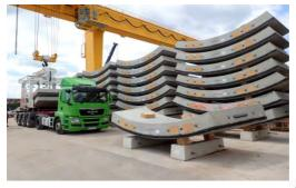
Eine Tunnelvortriebsmaschine gräbt mit ihrem Schneidrad ein großes rundes Loch in die Erde und kleidet dieses gleich mit Betonfertigteilen aus. Das läuft alles fast automatisch ab.
